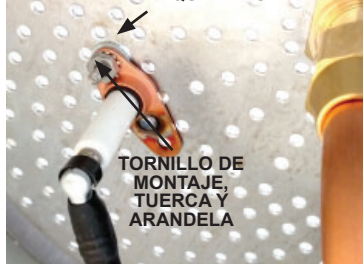
FIGURA 18 LA ARANDELA SE DEBE COLOCAR ENTRE EL ENCENDEDOR Y LA PLACA DEL QUEMADOR
